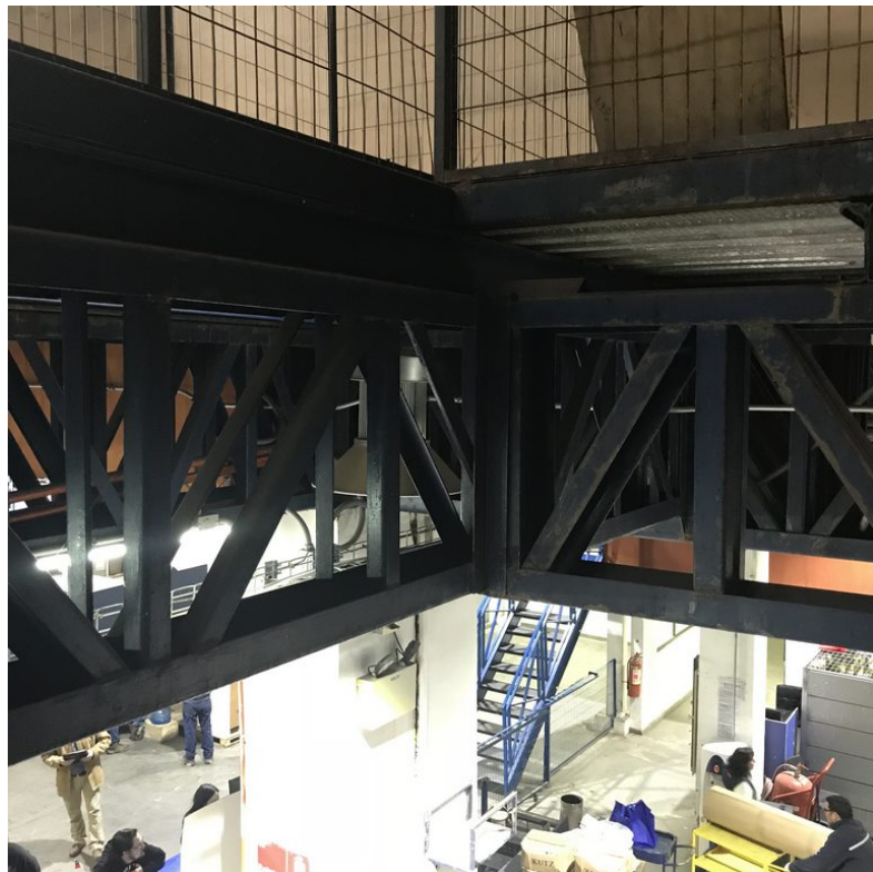
DETALLE ESTRUCTURA DE ENTREPISO, CON LOSA COLABORANTE.
