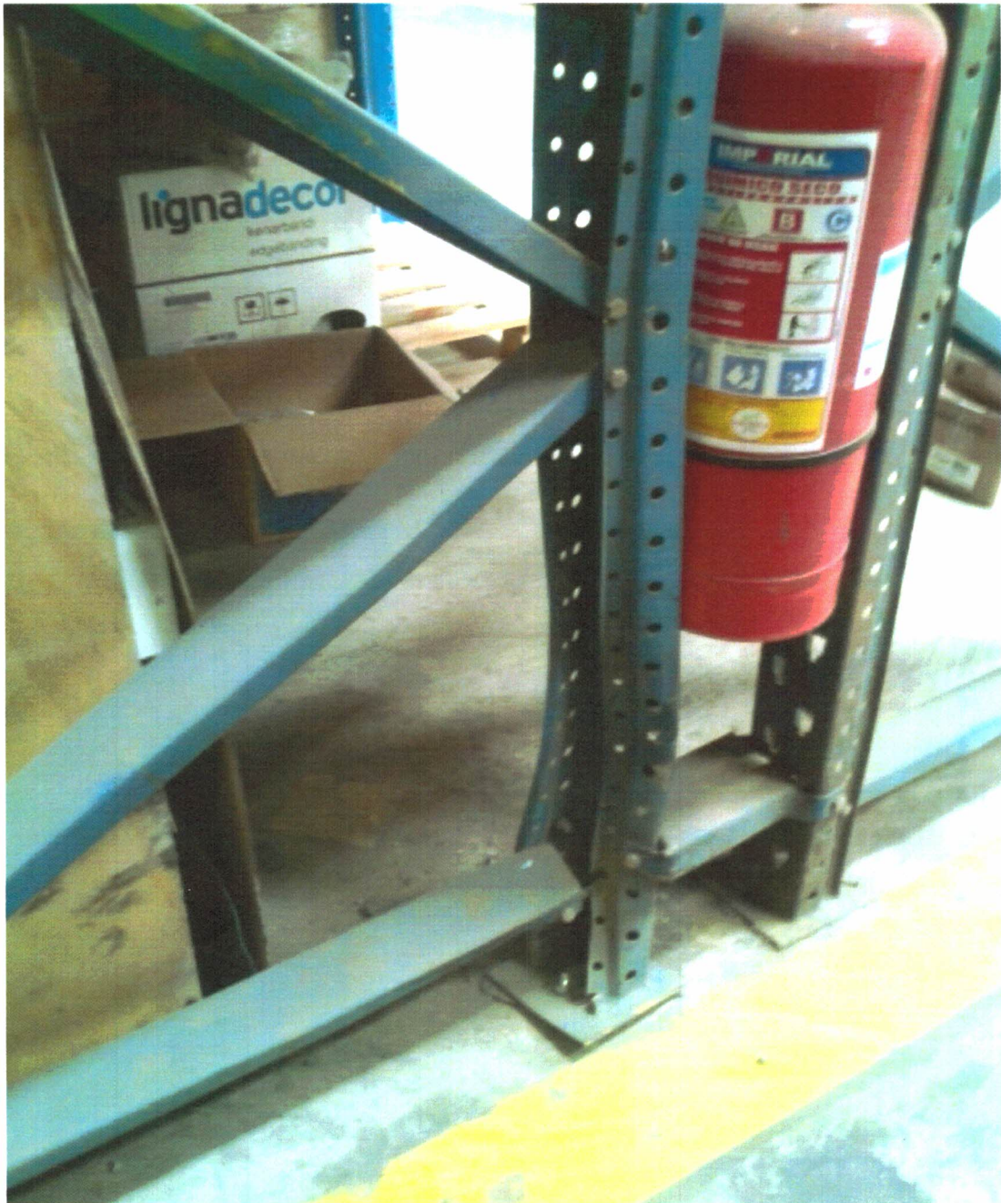
Fig. 7: VISTA DE PILAR GOLPEADO INFERIORMENTE.
