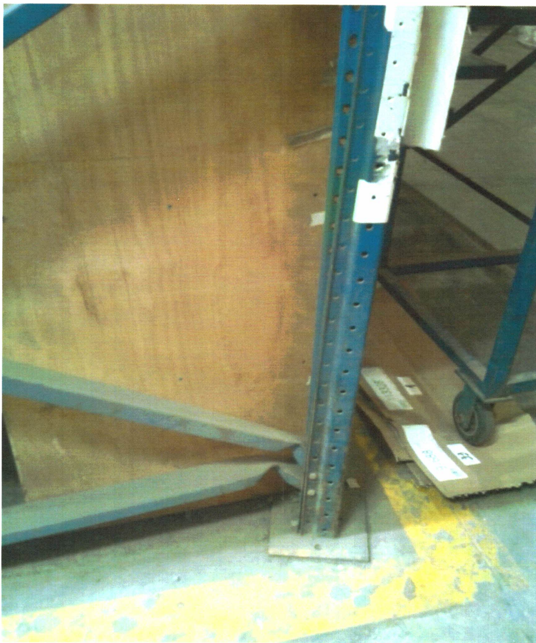
Fig. 8: VISTA DE PILAR GOLPEADO Y GIRADO, CON APOYO GIRADO Y SIN LOS RESPECTIVOS ANCLAJES.
