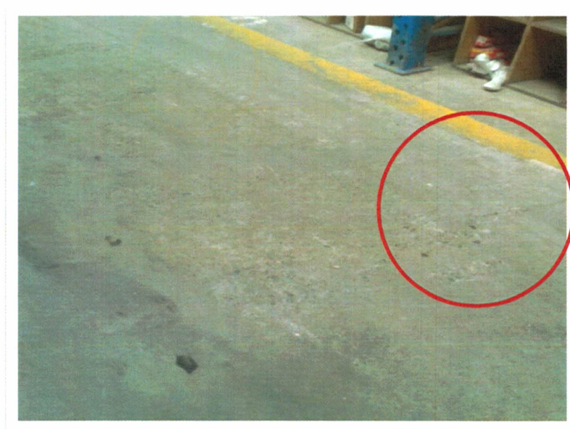
Fig. 4: Fig. 1: VISTA DE FISURAMIENTO Y DESINTEGRACIÓN.
