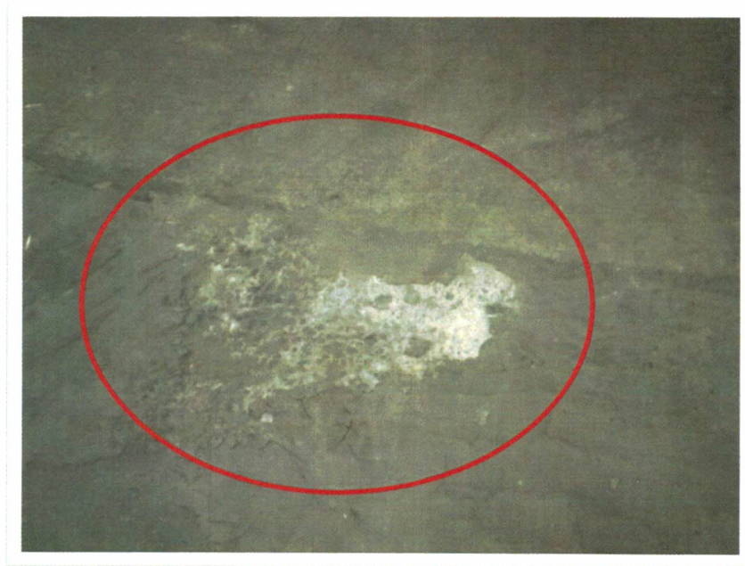
Fig. 1: PAVIMENTO CON DAÑO DE "DESINTEGRACIÓN".
