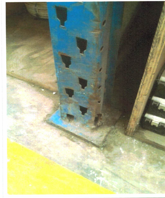
Fig. 9: VISTA DE PILAR DAÑADO Y OXIDADO, SIN PERNOS DE ANCLAJE EN PLACA BASE.
